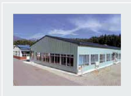
MIYAGI Fabbrica produttiva
